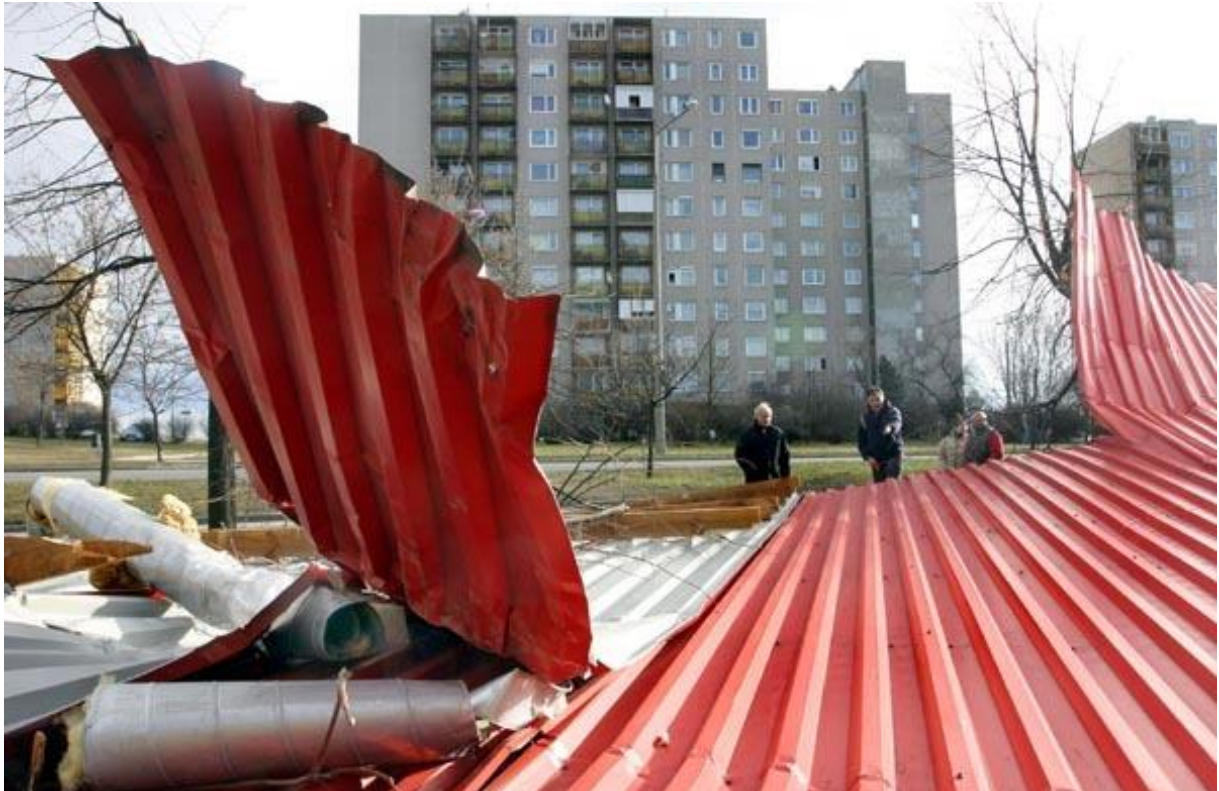
Ennek a T35-ös trapézlemeznek már nem kell több csavar (forrás: nol.hu)
